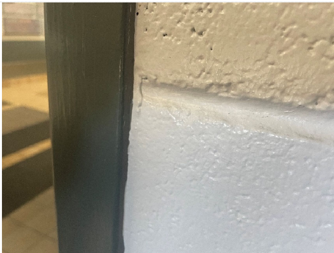
Door Frame Sealant
