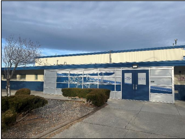
Entry (Building B)
